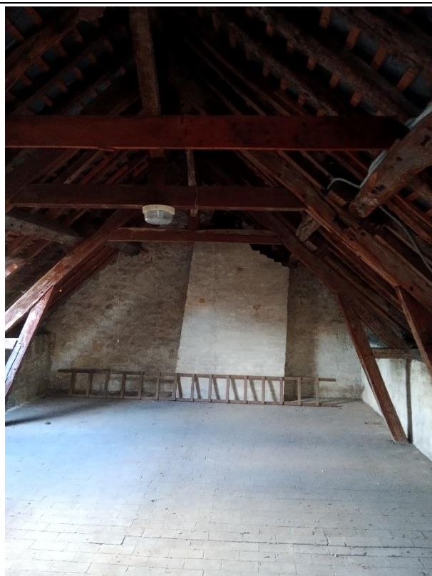
Plancher béton/brique sous combles perdus non isolés
