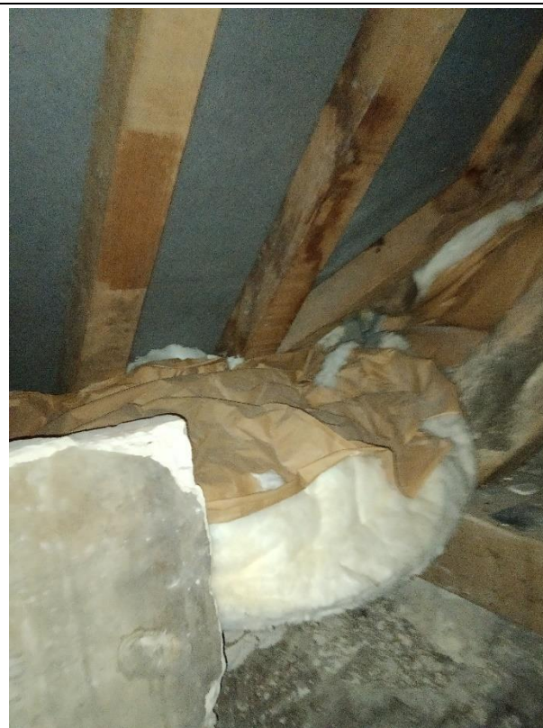
Rampants isolés avec 20 cm de laine de verre
