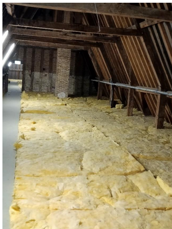
Plancher bois sous combles perdus isolés avec 22 cm de laine de verre
